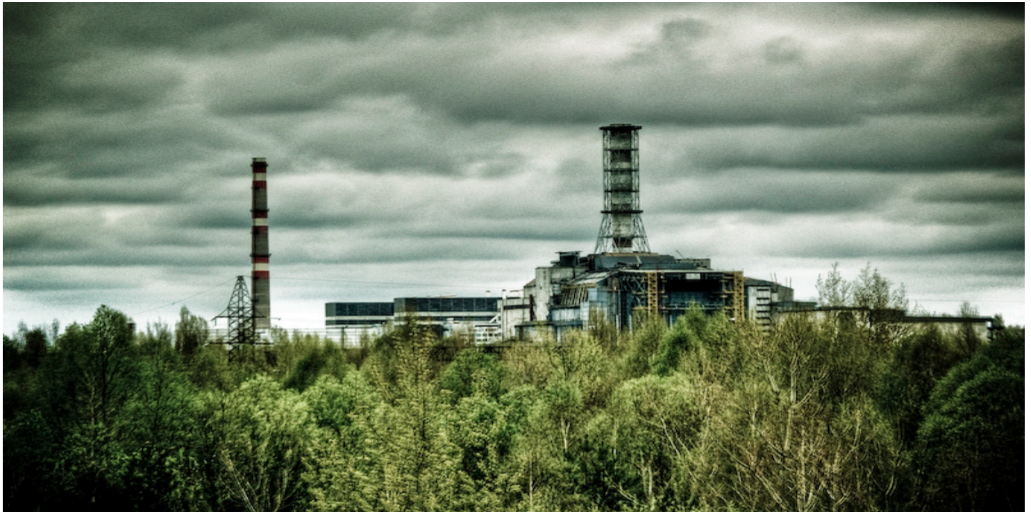
Widok na elektrownię w Czarnobylu, 2008 r. Fot. Wikimedia Commons/Ben Fairless (CC BY 2.0)
