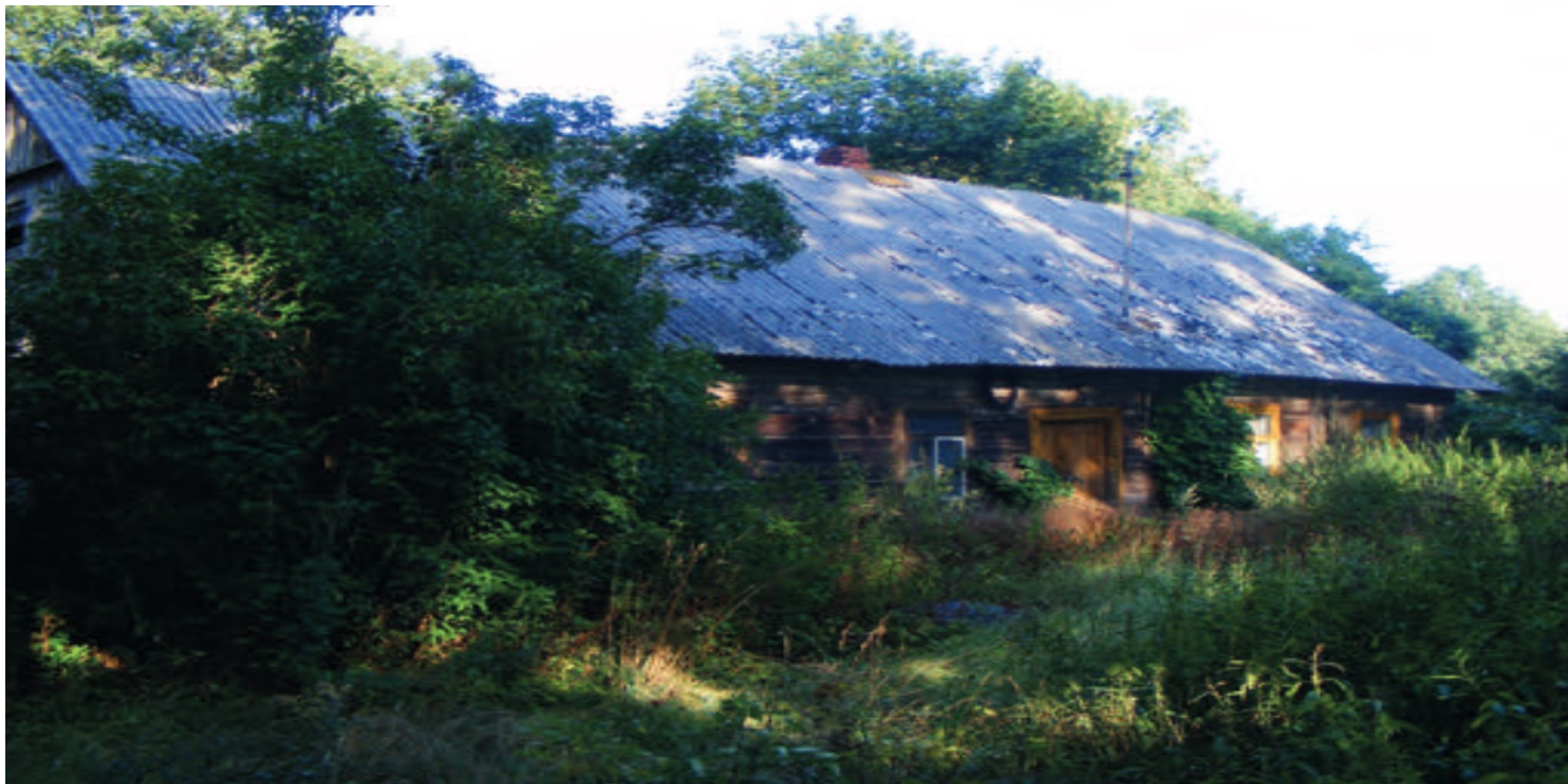
Budynek byłej strażnicy w Krejwianach; stan z sierpnia 2019 r. Fot. ze zbiorów Autora
