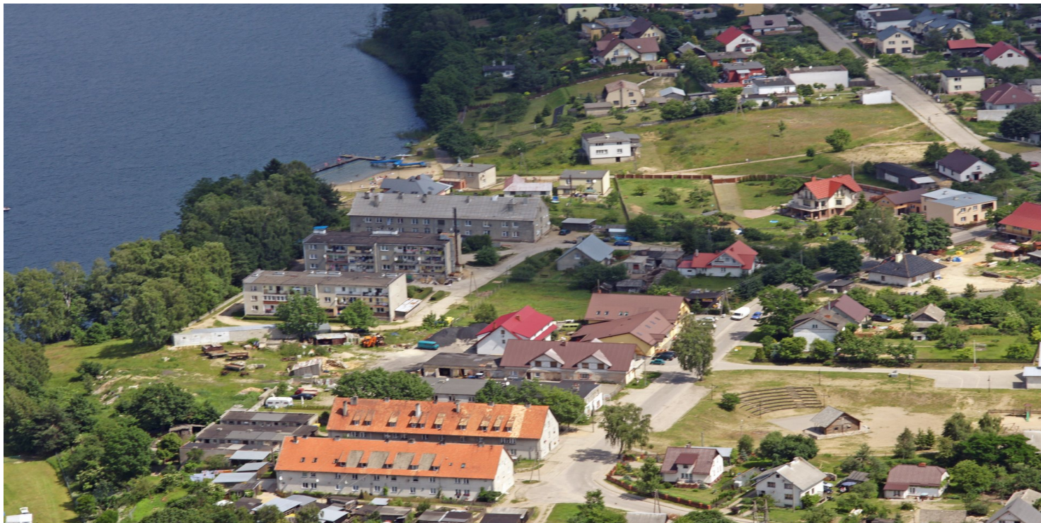
Widok Dziemian z lotu ptaka, na pierwszym planie widoczne budynki byłych koszar
