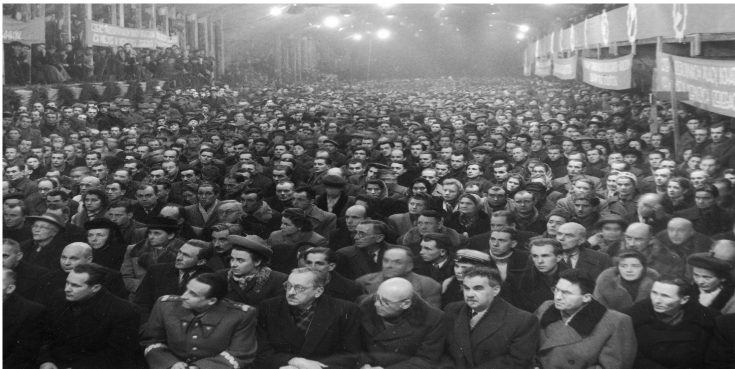
Wiec budowniczych warszawskiej Trasy W-Z z okazji wykonania zobowiązań podjętych dla uczczenia Kongresu Zjednoczeniowego PPR i PPS (fot. NAC)
