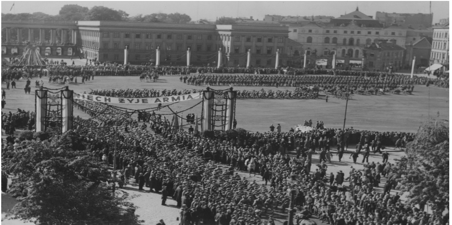
Powrót wojska po manewrach do Warszawy. Powitanie na placu Marszałka Józefa Piłsudskiego. Widoczne brama triumfalna i Pałac Saski, wrzesień 1936 r. Fot. ze zbiorów NAC
