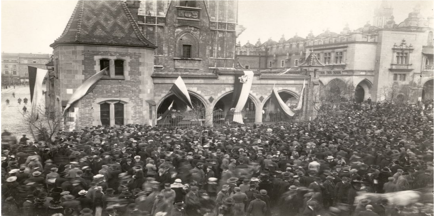
Przejęcie odwachu na Rynku Głównym w Krakowie
