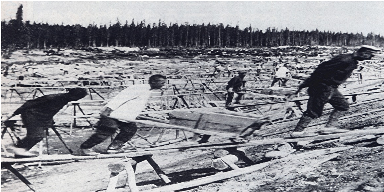
Więźniowie przy budowie Kanału Białomorsko-Bałtyckiego
