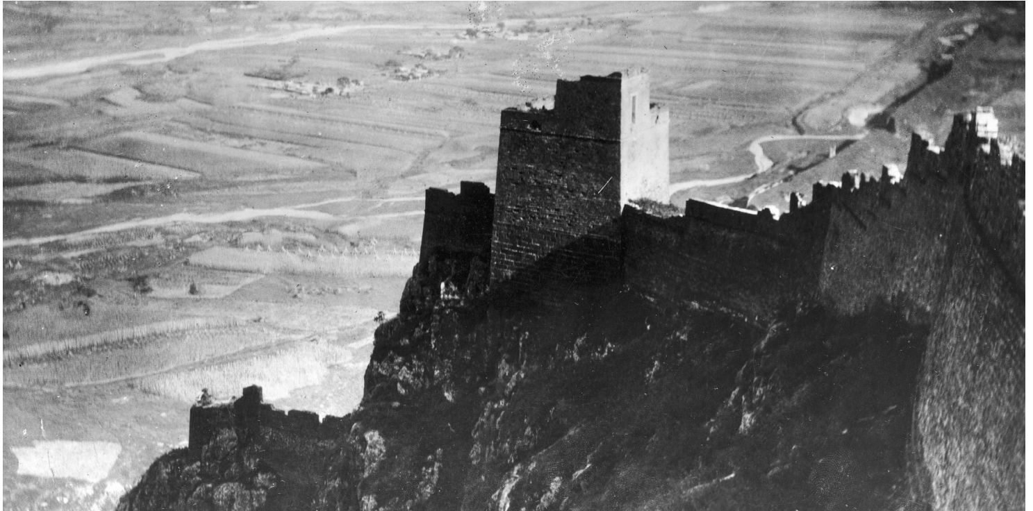
Twierdza Shanhaiguan, nad Zatoką Pohaj, wschodni kraniec Wielkiego Muru. Fot. NAC
