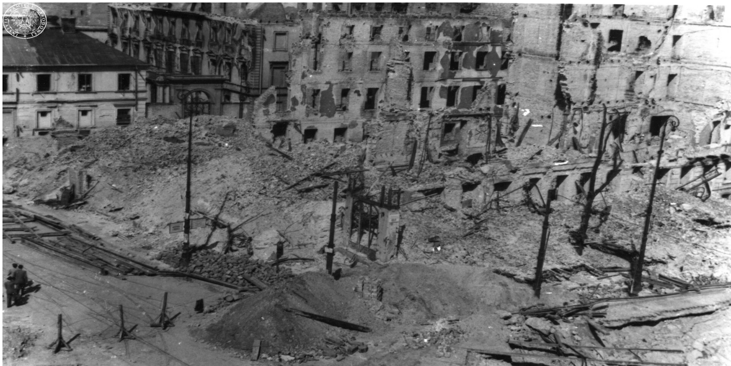
Zniszczenia kamienic na rogu Alei Jerozolimskich i Nowego Świata. Warszawa, lipiec 1945 r. Fot. z zasobu AIPN
