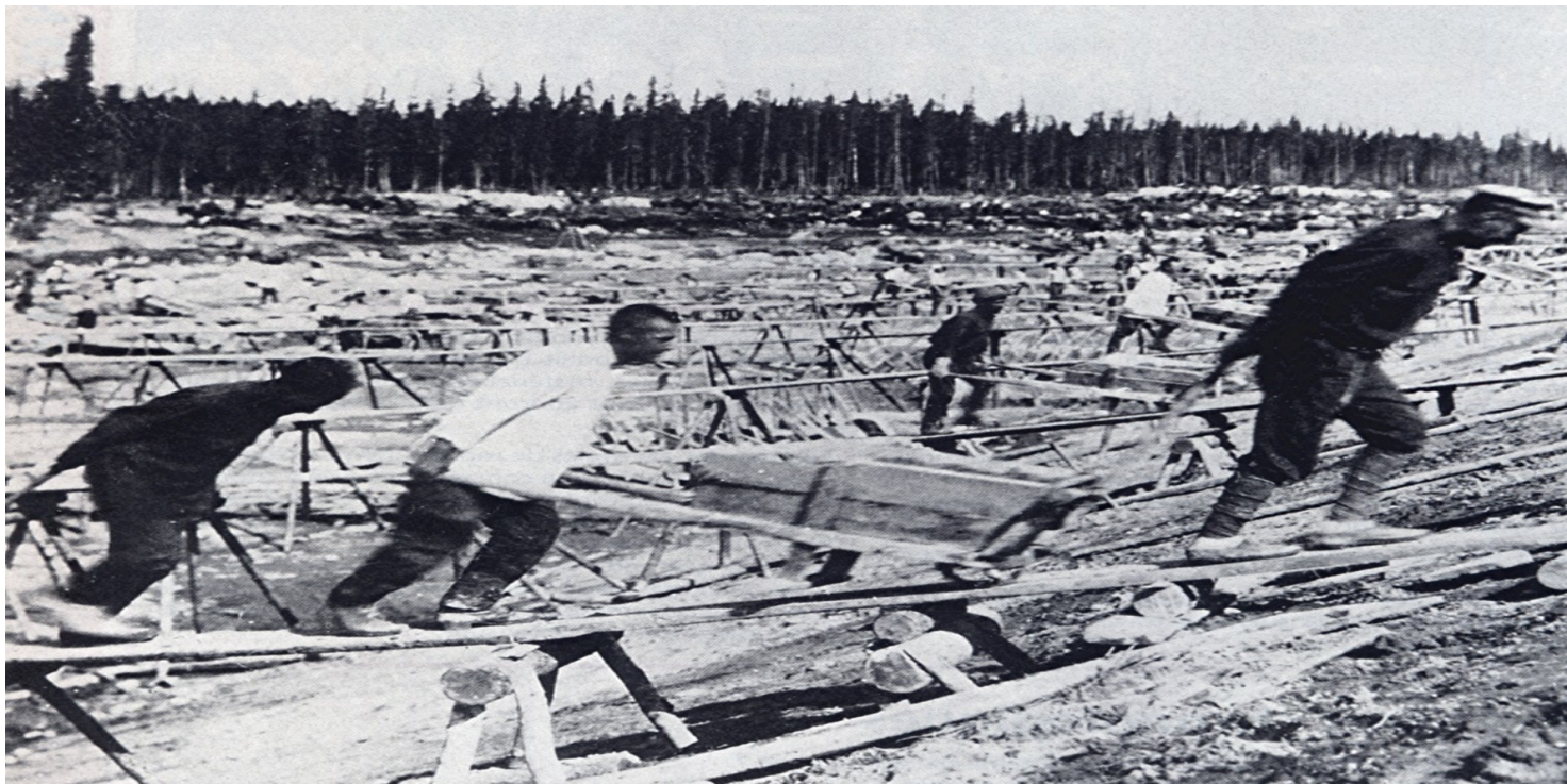
Więźniowie przy budowie Kanału Białomorsko-Bałtyckiego
