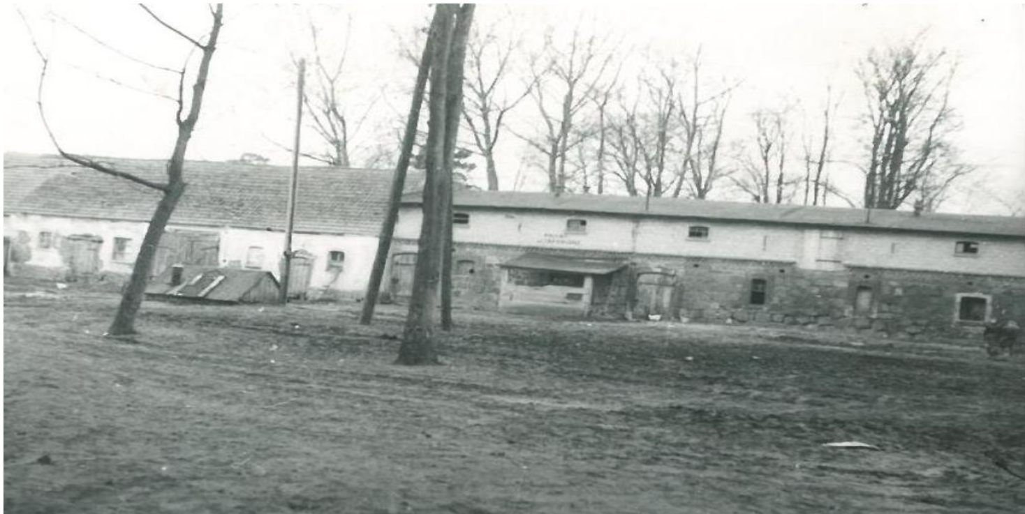
Budynek gospodarczy, w którym przetrzymywano więźniów. Fot. ze zbiorów IPN
