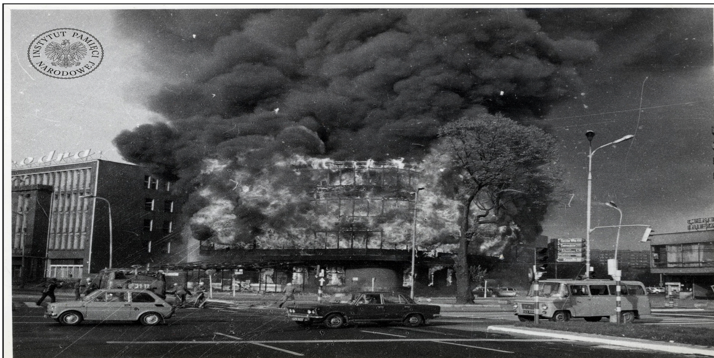
Płonący budynek Kombinat Gastronomicznego „Kaskada”, 27 kwietnia 1981 r. (fot. z zasobu IPN)
