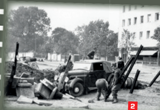
2 ▶ Budowa zapory przeciwczołgowej na Pradze, 10 września
