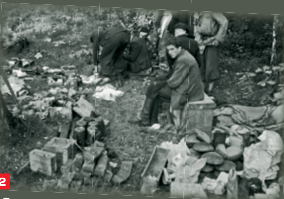
2 ▶ Sortowanie zaopatrzenia zdobytego w potyczce pod Wólką Pracką
