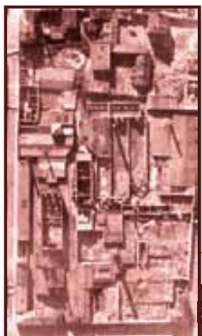
Kompleks Zakładów Norblinów
