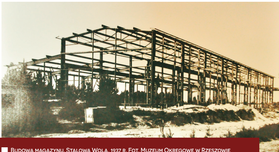
■ BUDOWA MAGAZYNU, STALOWA WOLA, 1937 R. FOT. MUZEUM OKRĘGOWE W RZESZOWIE
