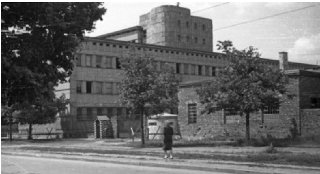
■ WARTOWNIA I BUNKIER PRZY BRAMIE KOSZAR NA UL. RAKOWIECKIEJ 4, GDZIE STACJONOWAŁ BATALION SS; NIEMCY WIEZILI TU MIESZKAŃCÓW WARSZAWY I PRZEPROWADZILI EGZEKUCJĘ 100 OSÓB, LIPIEC 1944 R. FOT. WIKIMEDIA COMMONS
