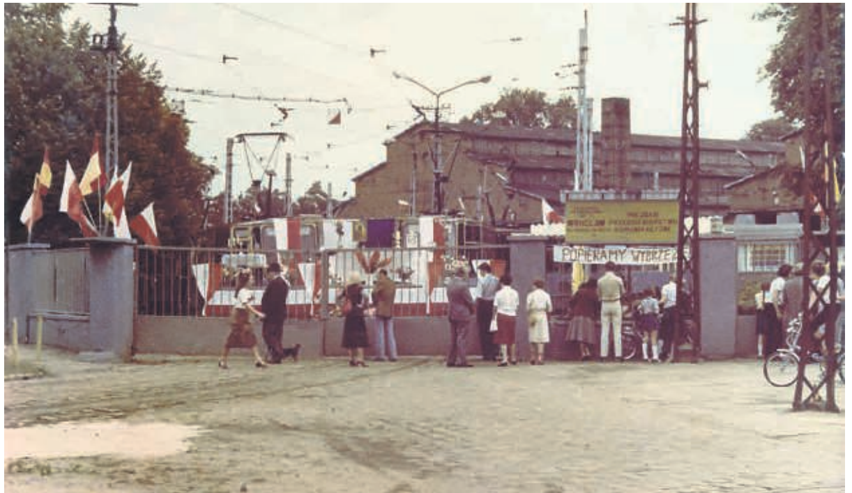
Zajezdnia Tramwajowa nr 6 Dąbie MPK we Wrocławiu przy ul. Wróblewskiego, sierpień 1980 r.
