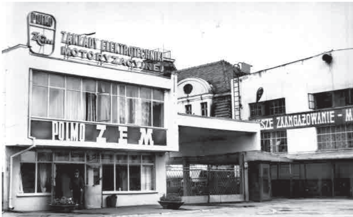
Zakłady Elektrotechniki Motoryzacyjnej „Polmo” w Dusznikach Zdrój - widok na bramę główną zakładu
