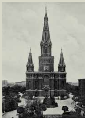
Kościół św. Jana w Łodzi wybudowano w latach 80. XIX wieku przy obecnej ul. H. Sienkiewicza, m.in. dzięki finansowemu wsparciu łódzkiego przemysłowca Karola Scheiblera. Była to wówczas druga ewangelicka świątynia w mieście. Po II wojnie światowej pieczę nad kościołem sprawuje zakon jezuitów, a swoją siedzibę ma w nim obecnie Parafia Najświętszego Imienia Jezus.
