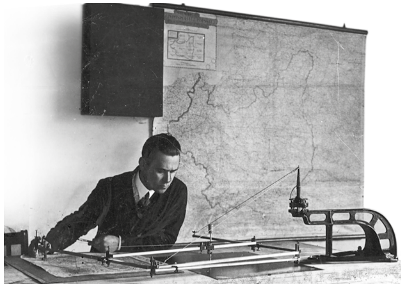
Wydział Kartograficzny Wojskowego Instytutu Geograficznego w Warszawie. Pantografowanie na blasze cynkowej pokrytej emalią. Fot. NAC
