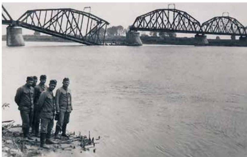
Most kolejowy pod Sandomierzem wysadzony przez grupę saperów 10 września 1939 r. na rozkaz gen. dyw. Tadeusza Piskora (domena publiczna)
