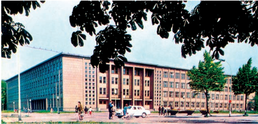
Wydział Budownictwa PŚ (do drugiej połowy lat 70. Wydział Budownictwa i Architektury)
