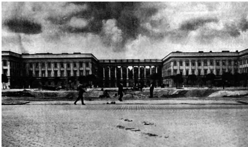
Plac Saski w ostatniej fazie niwelacji terenu po byłym soborze (fot. Marian Fuks) 108
